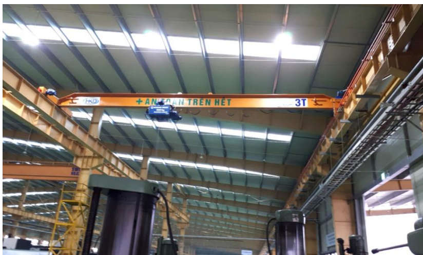
Hình 6. Cầu trục dầm đơn 3 tấn, dầm chữ I tổ hợp. Nguồn: [3]
